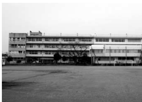
校舎耐震補強工事を行う伊奈中学校
