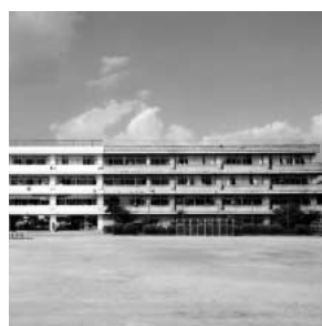
校舎耐震補強工事(第2期)を行う南小学校
