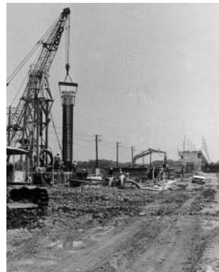
昭和55年、 東北新幹線工事 の進む本区地区
