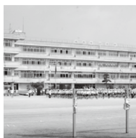
耐震補強設計を実施する南小学校
