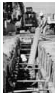
整備の進む下水道
