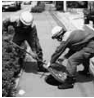
水利調査（消火栓の確認）
