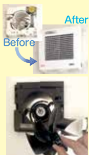
ファンの取り外しが可能な換気扇に交換
