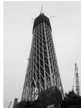
「建設中の東京スカイツリー」 撮影:加藤 和子(羽真)
