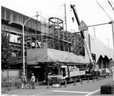
博物館開館にあわせて改修の進む大成駅
