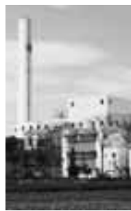
ゴミ処理施設 (クリーンセンター)
