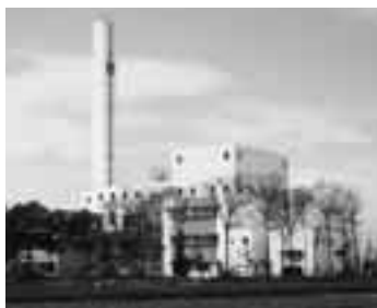
ゴミ処理施設（クリーンセンター）
