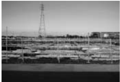
完成の待たれる（仮称）小針北小学校
