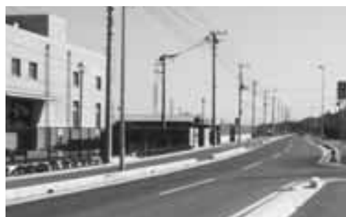
整備の進む農免道路（大針地内）
