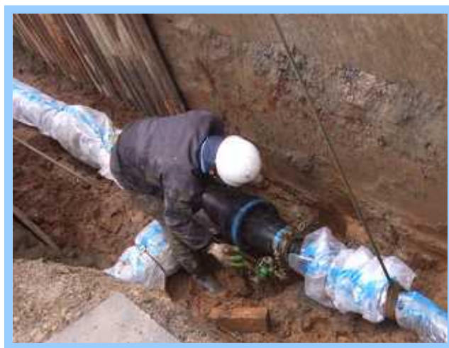
配水管更新工事
