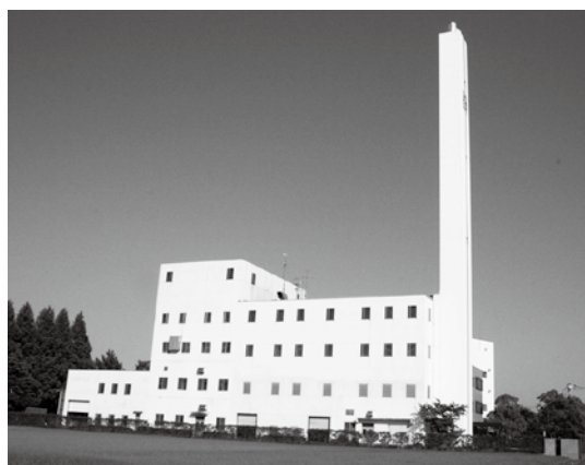
▲伊奈町クリーンセンター
