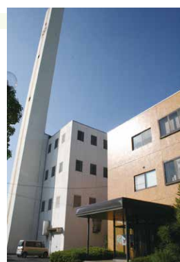
▲伊奈町クリーンセンター
