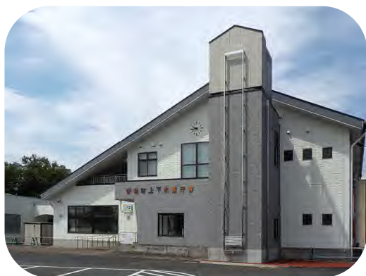
上下水道庁舎
